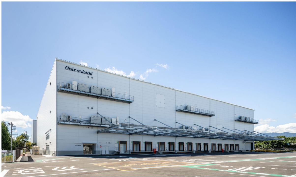
▲ORD厚木冷凍ステーション外観
